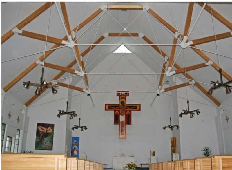
Fot.5.8 Kościół w Łodzi, rozpiętość 18,5 m (fot. E.I. Kotwica)
