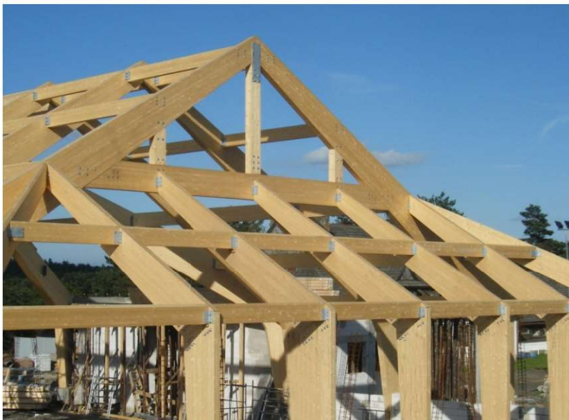
Fot. 2.7 Konstrukcja z drewna klejonego warstwowo przekrycia ujeżdżalni (fot. E.I. Kotwica)
