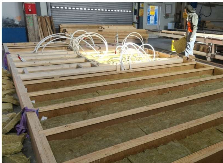
Fot. 5.12 Prefabrykacja stropu o konstrukcji szkieletowej (fot. P. Sulik)
