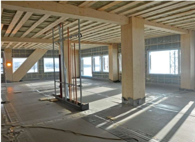
Fot.5.11. 18-kondygnacyjny budynek Mjøstårnet w Brumunddal na etapie montażu (fot. T. Birgersson)
