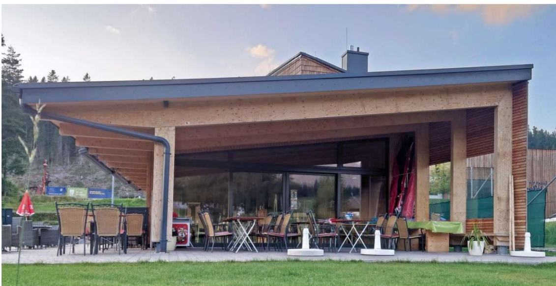
Fot. 2.12 Przykładowe zastosowanie LVL jako konstrukcji nośnej obiektu zaplecza przy kortach tenisowych, Seefeld. (fot. E.I. Kotwica)
