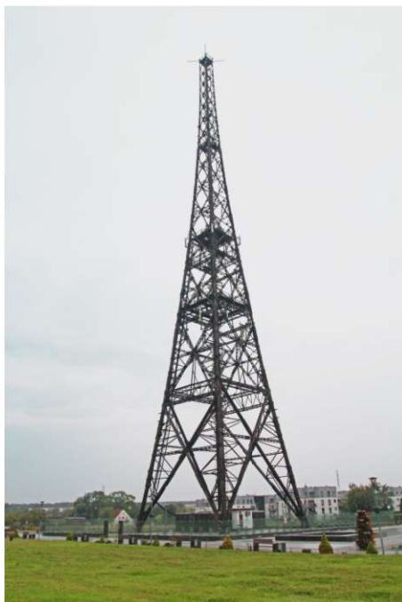
Fot. 1.8 Wieża antenowa w Gliwicach, (fot. E. I. Kotwica)
