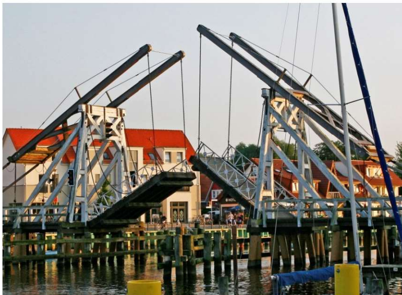
Fot. 1.7 Most w Greifswaldzie, (fot. E. I. Kotwica)
