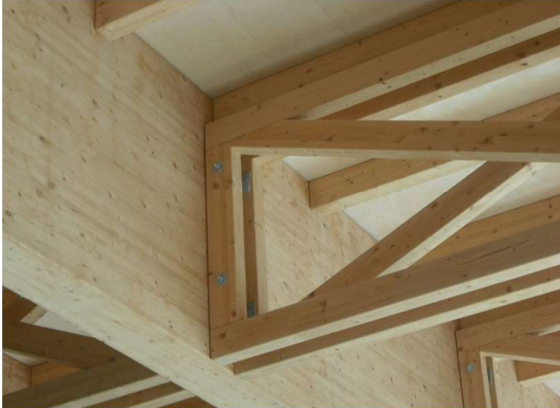
Fot. 4.13 Tężniki drewniane kratowe (fot. P.Sulik)
