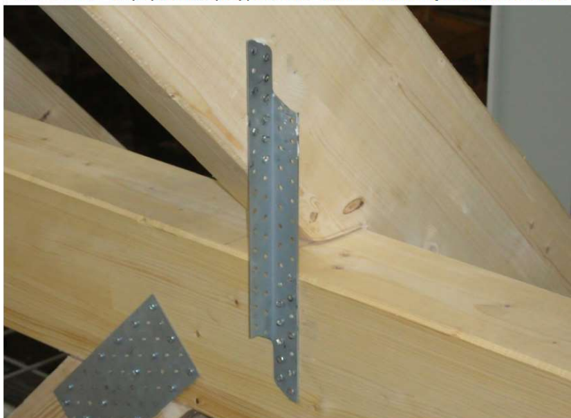
Fot. 7.27 TAK. Poprawnie wykonane połączenia z wykorzystaniem łącznika krokwiowego projektowo dobranej ilości łączników. (fot. T. Szczesiak)
