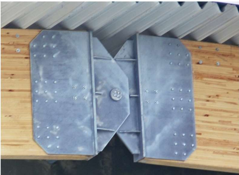
Fot. 7.31 TAK Przegub kalenicowy (fot. P. Sulik)
