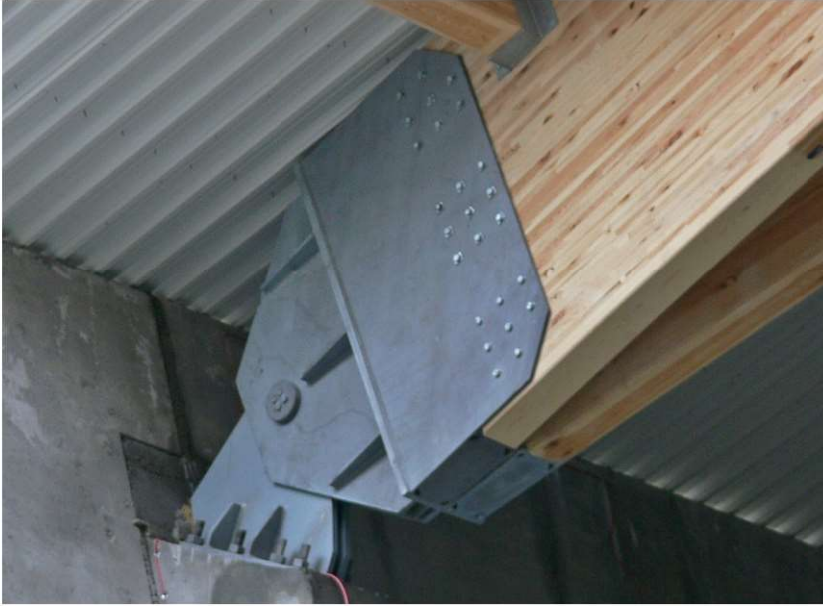
Fot. 4.8 Detal przegubowego węzła podporowego (fot. P.Sulik)
