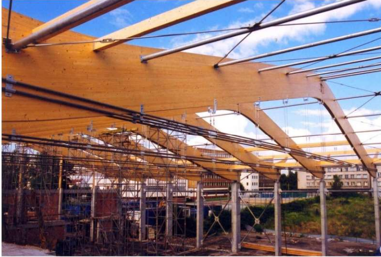
Fot. 1.12 Konstrukcja przekrycia hali sportowej AWF Katowice. (fot. E. I. Kotwica)
