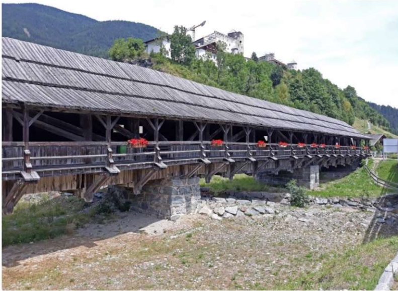
Fot.5.5. Drewniany most z 1781 roku o całkowitej długości 66 m, Austria, Panzerdorf (fot. P. Sulik)
