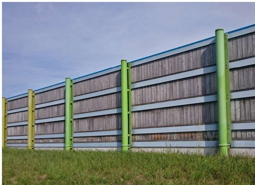
Fot.5.2. Ekrany akustyczne (fot. E. I. Kotwica)
