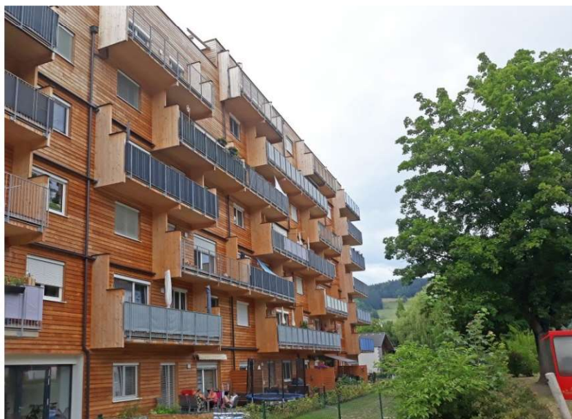
Fot.5.1. Budynek wielorodzinny w Leoben, w Austrii (fot. P. Sulik)
