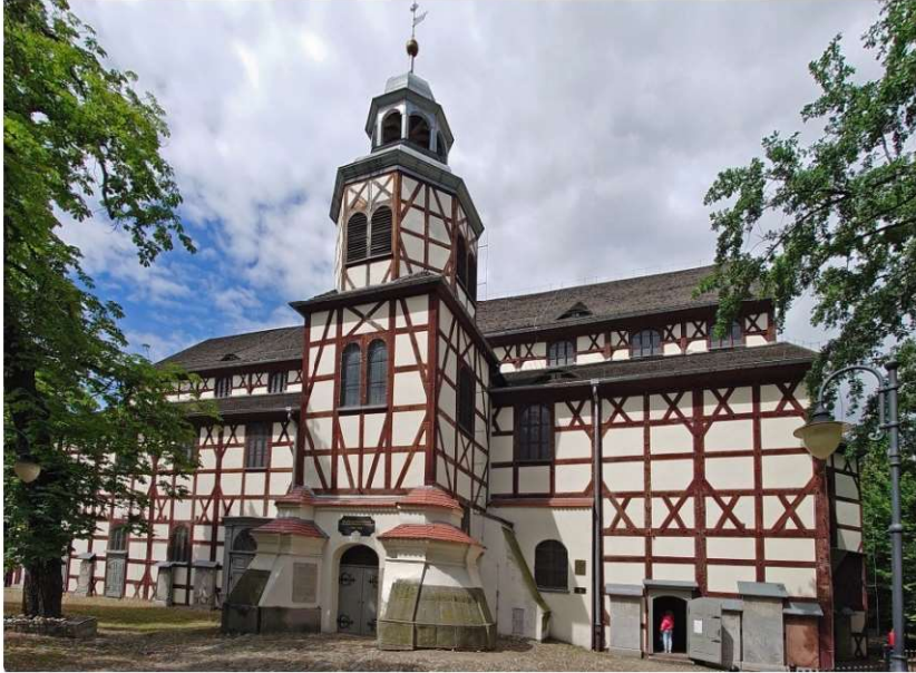
Fot.1.5. Świątynia Pokoju w Jaworze z 1655 r. (fot. E. I. Kotwica)
